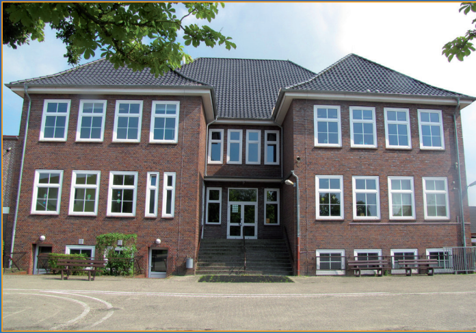
Den Bau einer neuen Grundschule in Bunde
